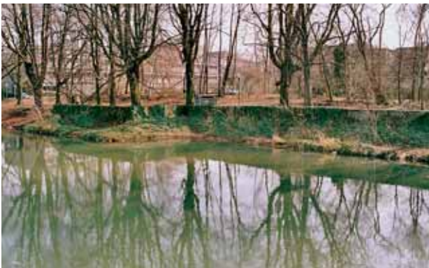
Abb. 25: Von einer Mauer eingefasstes, erweitertes Becken am westlichen Ende des Clarenbachkanals
