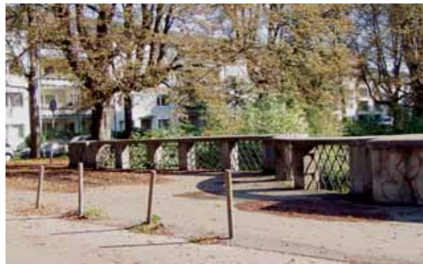
Abb. 26: Durch unterschiedliche Gitterelemente durchbrochene Abschlussmauer des Clarenbachkanals
