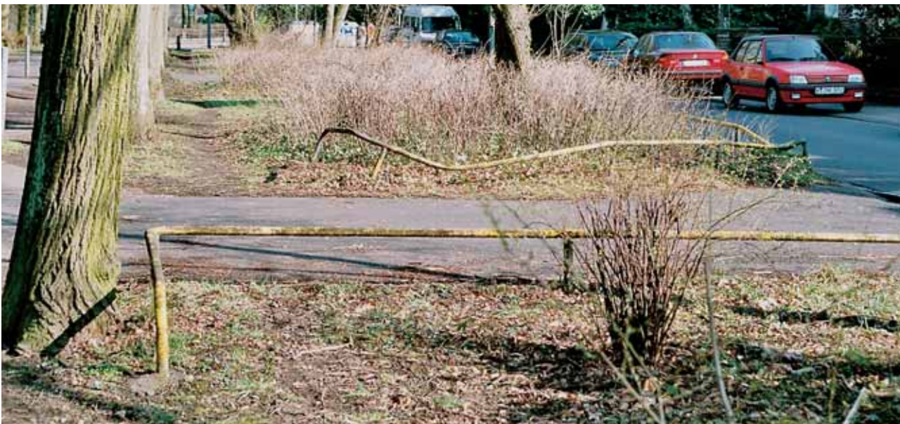
Abb. 53: Defekte und ungepflegte Begrenzungsgitter entlang der Gehölzstreifen und Böschungen
