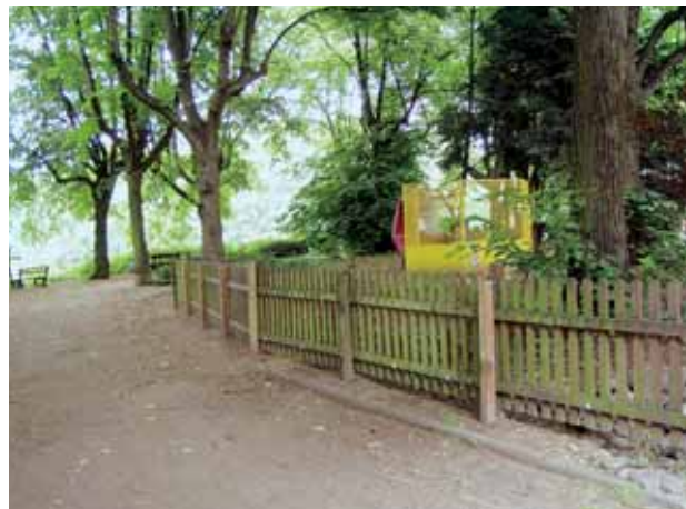
Abb. 94: Trennungszäun zwischen Hotelterrasse und übriger Terrasse
