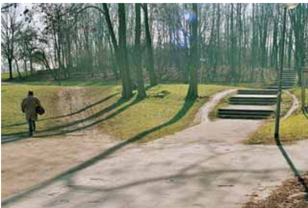
Abb. 11: Radspuren neben der Treppenanlage
