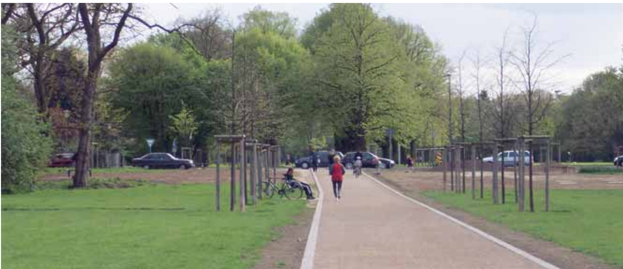
Abb. 4: Blick auf die Vogelsanger Straße nach der Sanierung
