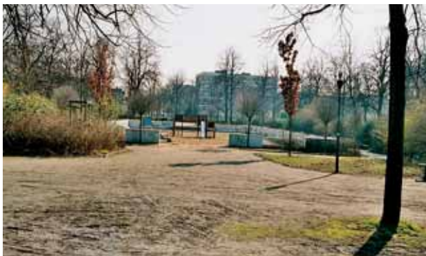
Abb. 35: Beschädigte Wegedecke zwischen Wasserbecken und Spielplatz
