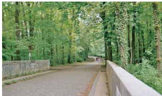
Abb. 61: Gepflasterte Wegdecke auf der Brücke
