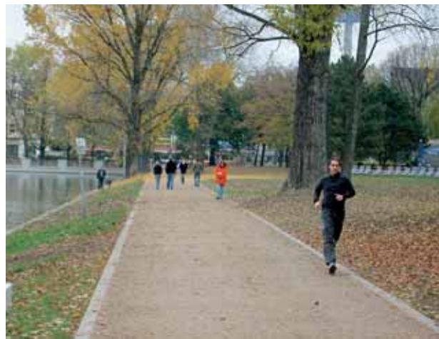
Abb. 5: Sanierter Weg, wassergebunden mit Randeinfassung, am Aachener Weiher
