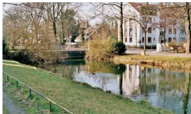
Abb. 47: Ausgewachsene Sträucher an den Brücken
