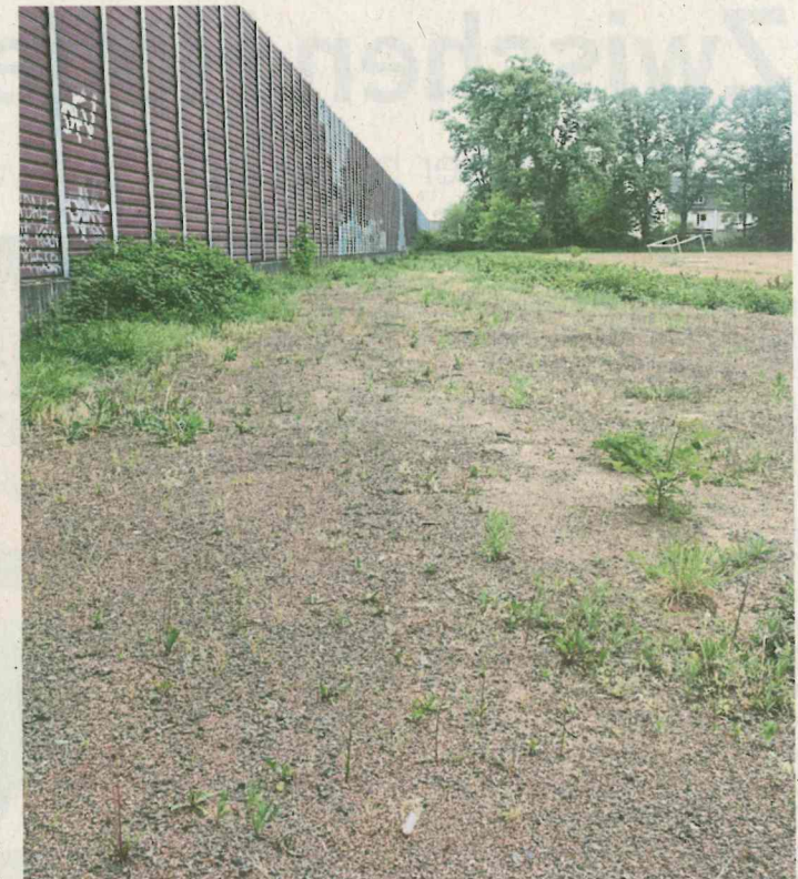
Zwischen Lärmschutzwand und MTV-Plätzen wird der Äußere Grüngürtel wieder etwas mehr geschlossen. Foto: Hoeck
