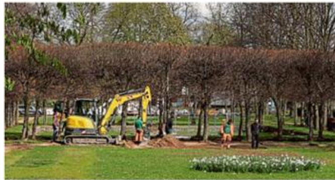
Sanierung der Alhambra im Inneren Grüngürtel in Nippes
