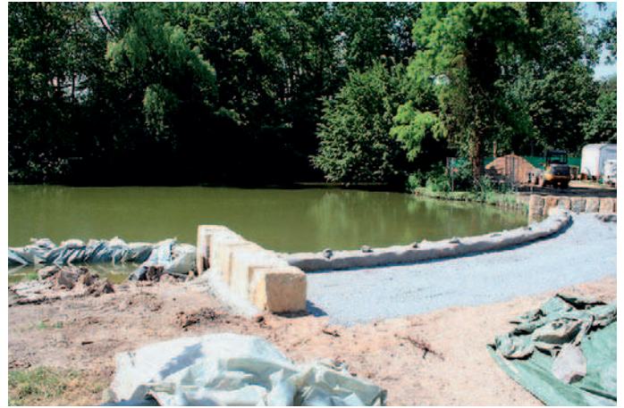
Juli 2007: Arbeiten schreiten schnell voran
