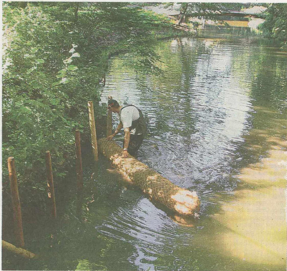
Kokoswalzen werden am Ufer des Weihers an der Dürener Straße befestigt, in die später Schilf gepflanzt werden kann. Im Lauf der Zeit verrottet das Kokosmaterial, Wurzeln sollen dann das Ufer stabilisieren. BILD: EIC
