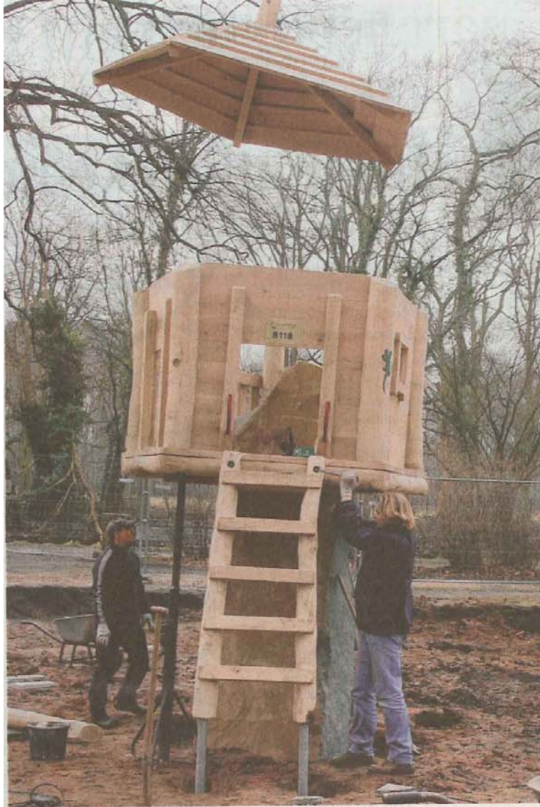
Ein Kran trägt das Dach heran. Das neue Spielhaus ist eine Attraktion für Mädchen und Jungen.
